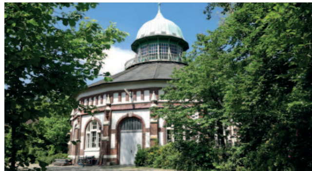
Hohe Ward Wasserwerk, Foto: A. Tecker
