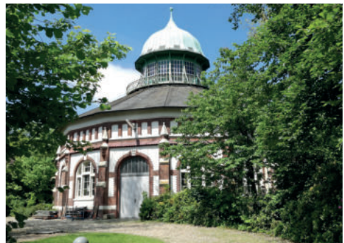
Hohe Ward Wasserwerk, Foto: A. Tecker
