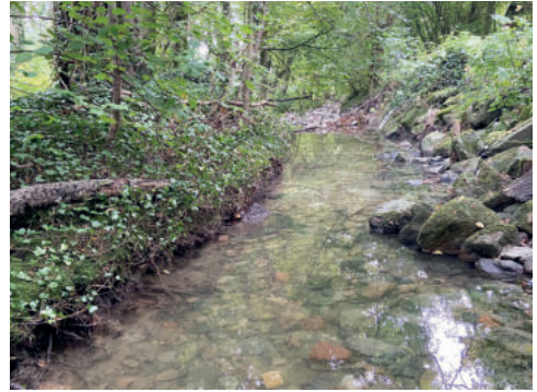
Gaßbach in Stromberg, Oelde, Foto: A. Pruhs
